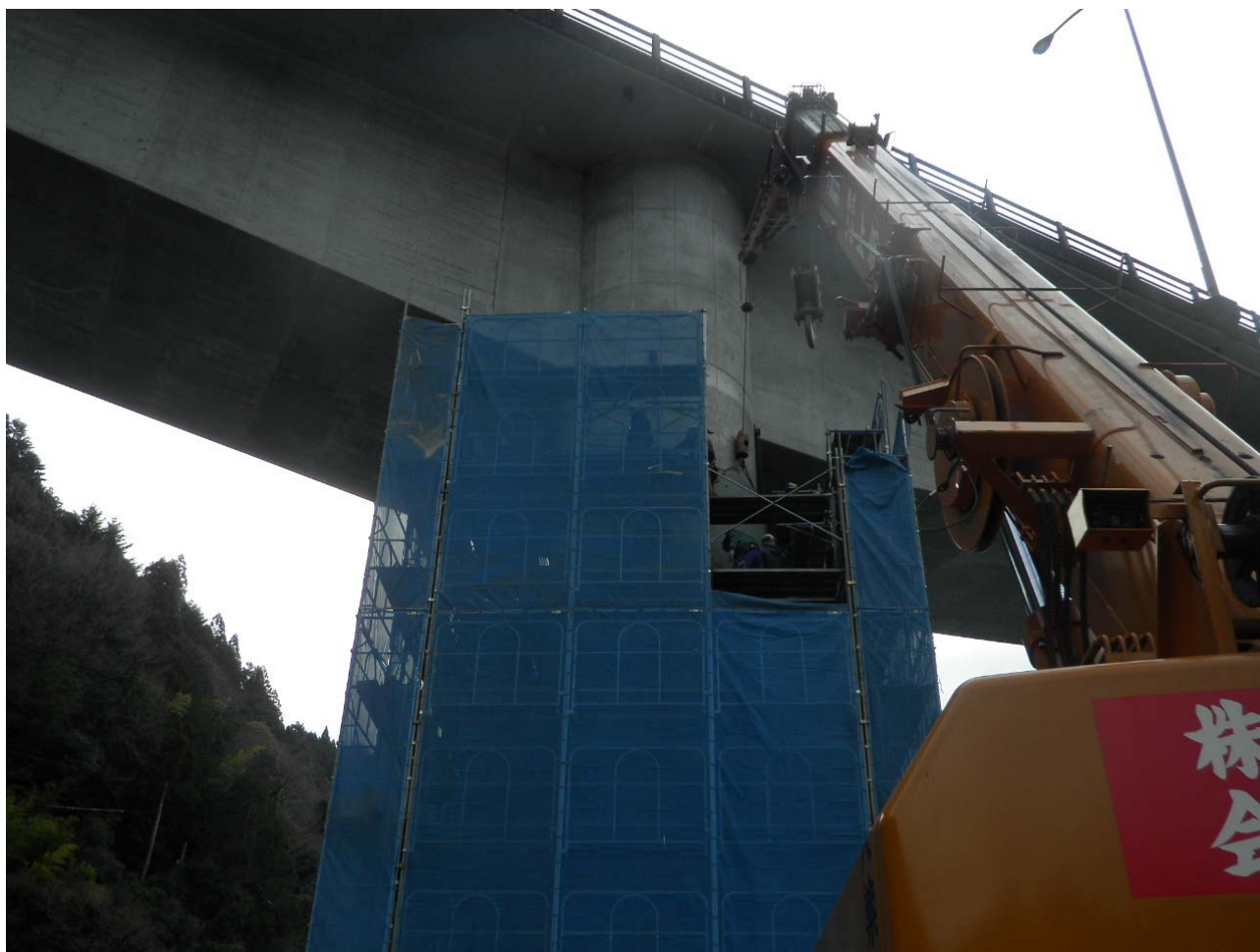
(県土木(国) 362号 柳崎大橋 橋脚耐震補強工事)
