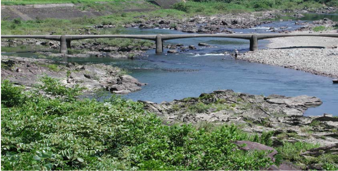
日本最後の清流 四万十川の沈下橋
