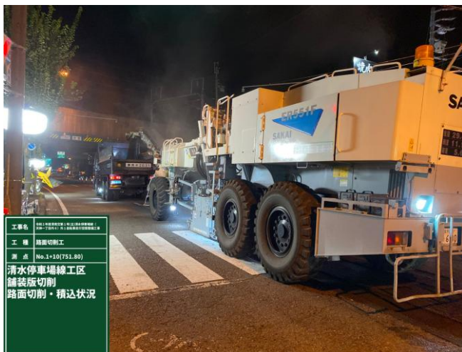
切削機を用いた施工
