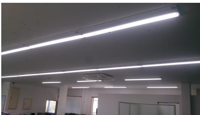
2F事務所蛍光灯を灯器具から交換をしました。 今後の電力の消費量を見極め 契約電力の見直しを検討する。
