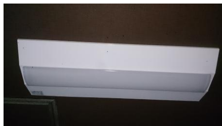
照明器具をLED照明器具へ交換
