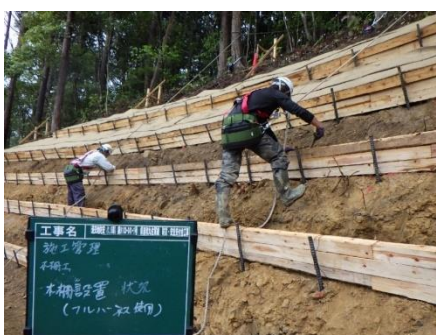
▲ 県内産木材を使用した木製型枠・木柵の設置 安全掲示板にも間伐材を使用しています。
