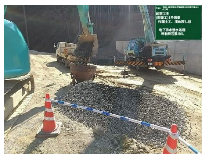
▲ 単粒砕石の敷き均し
