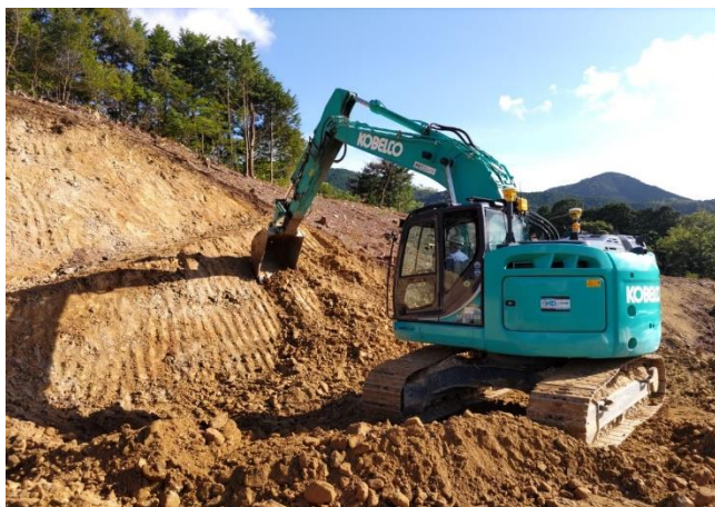
▲ 掘削状況 (MG-BH0.8㎡)
