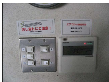
○消灯シール、エアコン設定温度シール貼付け
