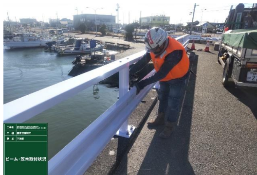
小川橋橋梁補修工事 ガードレール取替
