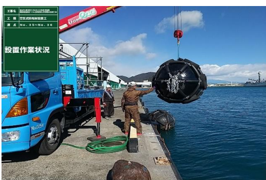
焼津港防舷材設置工事 防舷材設置
