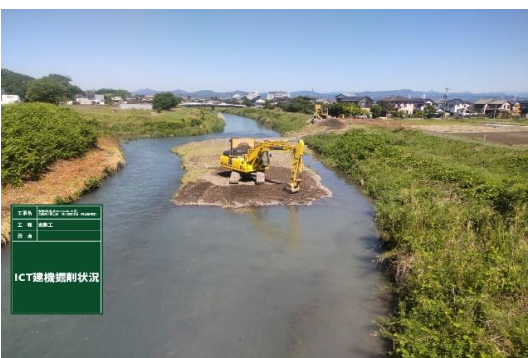
栃山川河川浚渫工事 河床掘削
