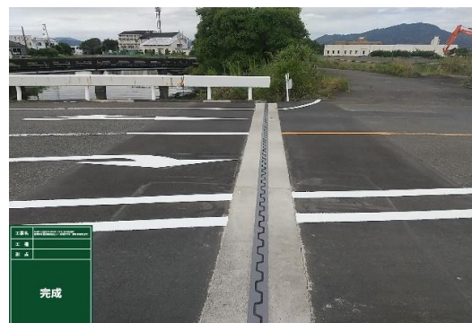
小川橋橋梁補修工事 伸縮装置取替
