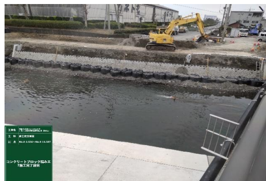
志太東幹線護岸工事 ブロック積み護岸
