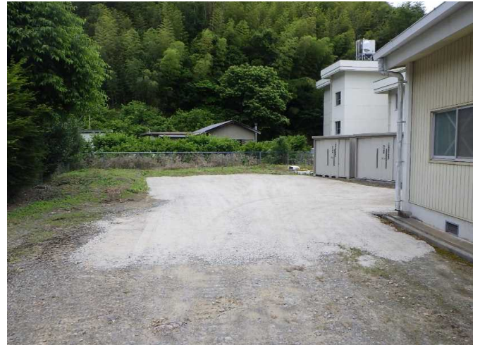
地域貢献活動 土佐市北地:土佐市立北原小学校 砕石敷均し 施工後
