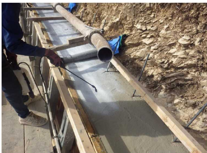
・道路改良工事での散水状況 市道の粉塵低減
