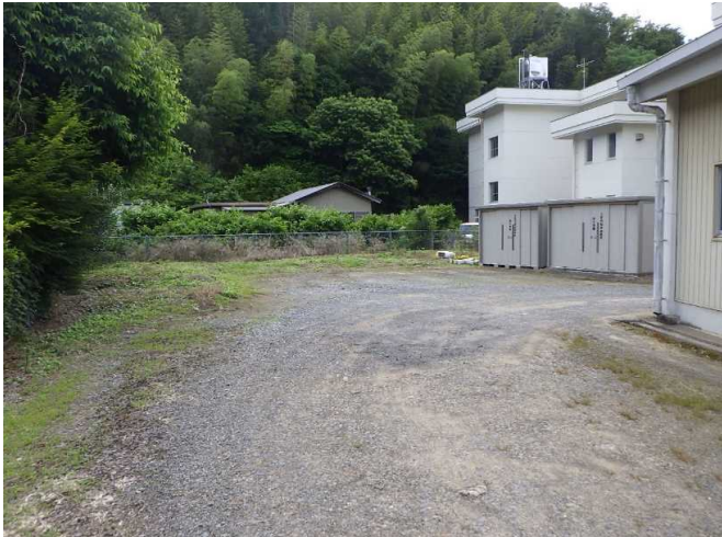
地域貢献活動 土佐市北地:土佐市立北原小学校 砕石敷均し 施工前
