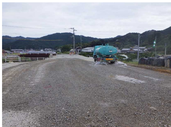
・道路改良工事での散水状況 仮設道の粉塵低減
