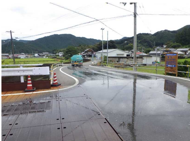
・道路改良工事での散水状況 市道の粉塵低減
