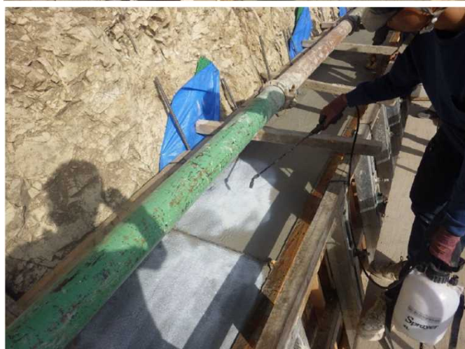
・急傾工事でのコンクリート打継処理状況 フリード・ボンド工法による水質汚濁防止
