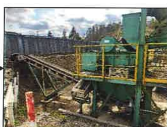
②RC-13オーバー選別状 況
