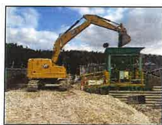
①アスファルトRC-40 投入状況
