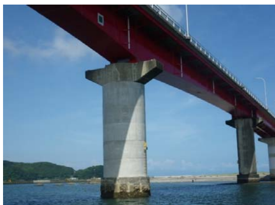
橋梁耐震補強 橋脚巻立工 完成
