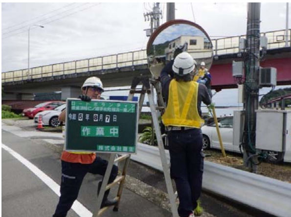
カーブミラー清掃 A（県道須崎仁ノ線） 高知県管轄
