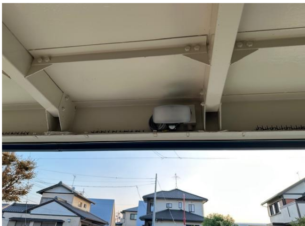
センサー照明の設置
