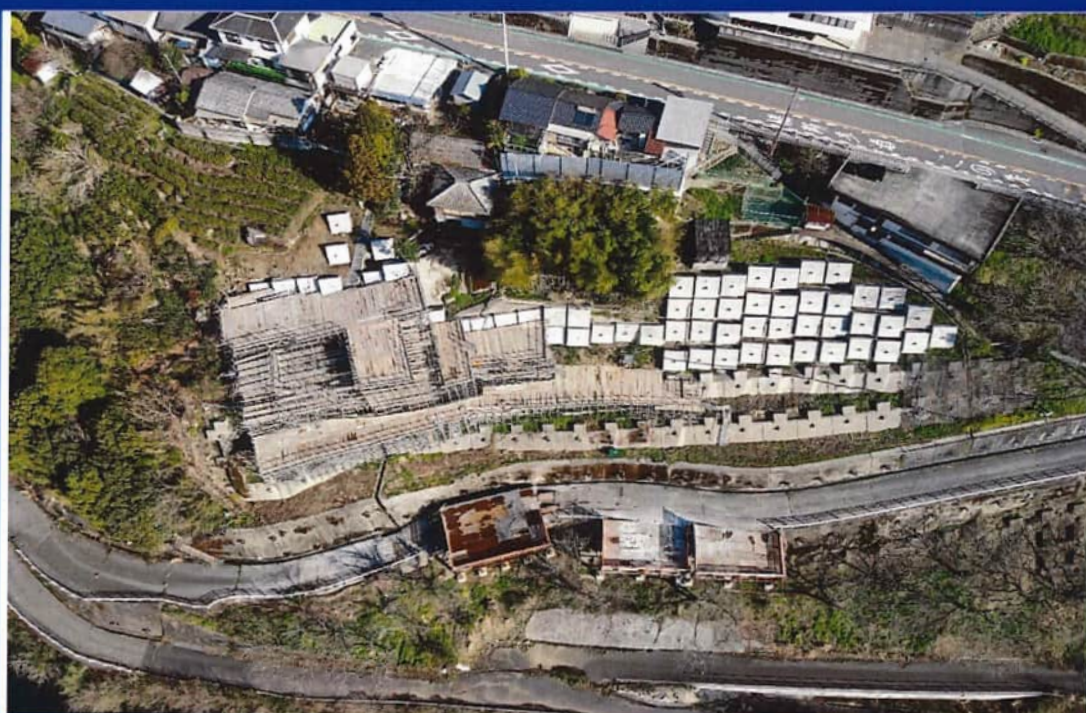
令和5年度森山地区地すべり対策工事 優良工事局長表彰
