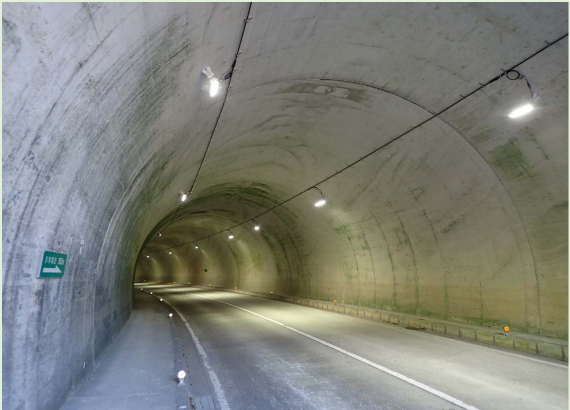
国道381号 トンネル修繕(浦越トンネル)工事 (場所: 四万十町)
