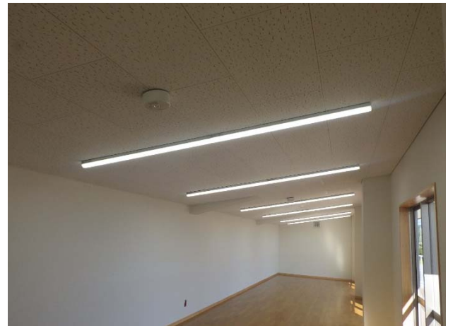
野市東防災コミュニティセンター新築工事(電気設備) (香南市)
