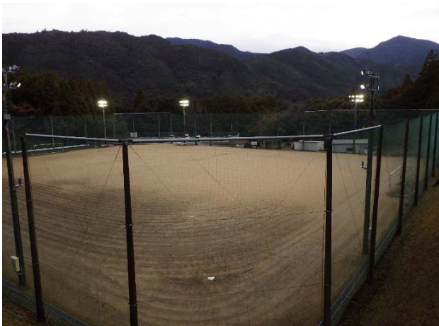
令和5年度 香美市香北グラウンド照明取替工事 (香美市)
