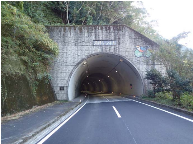
国道381号 トンネル修繕(浦越トンネル)工事 (四万十町)
