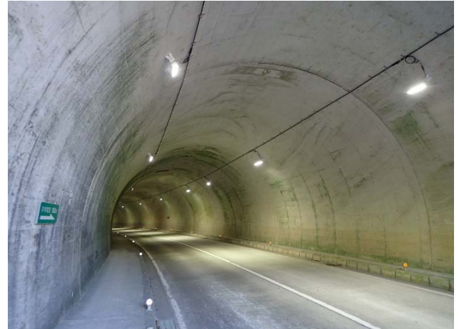
国道381号 トンネル修繕(浦越トンネル)工事 (四万十町)
