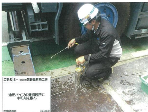
実施状況 (損傷箇所のオイル漏れ部分に中和剤を散布)
