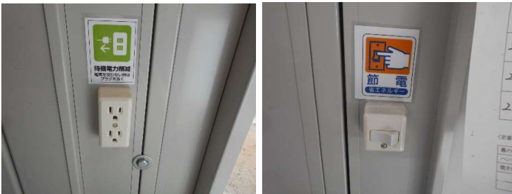
(現場事務所内)
