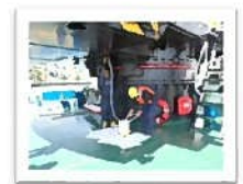
吸着マット敷設
