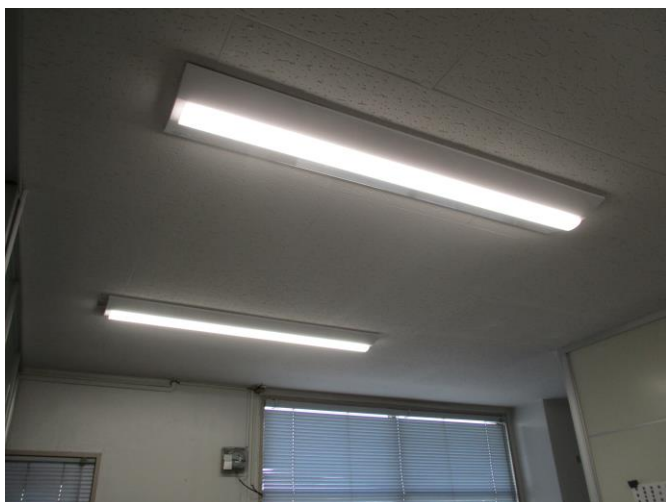
事業所内の蛍光管を LED に変更して節電活動
