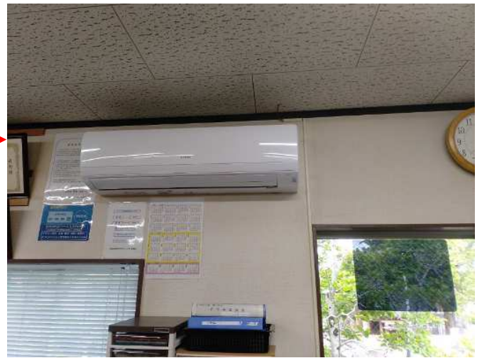
(取替え後(エアコン))
