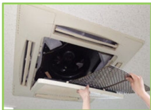
エアコンフィルター取付による省エネ
