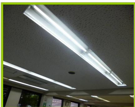
LED照明の導入
