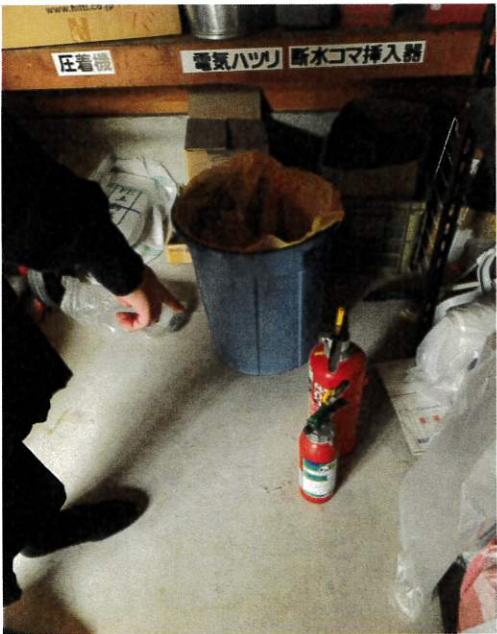
消火器等の確認の様子
