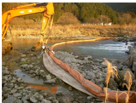
河川工事で汚濁防止フェンスを設置して下流への濁水流出を予防。
