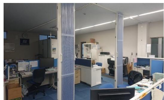
第二工事部室内に間仕切りを設置
