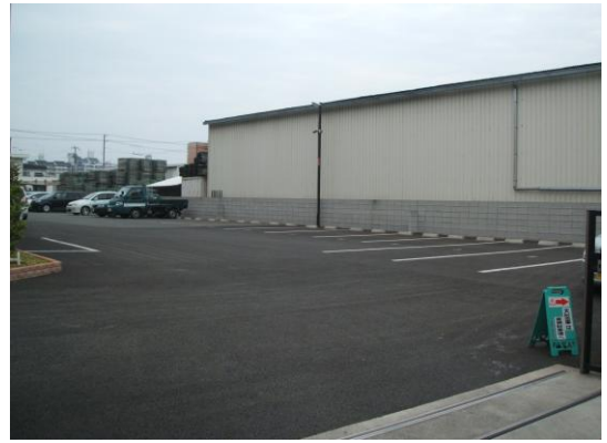
開粒度アスファルトの駐車場
