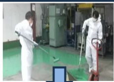
根洗工場 床塗装 2024.8.11
