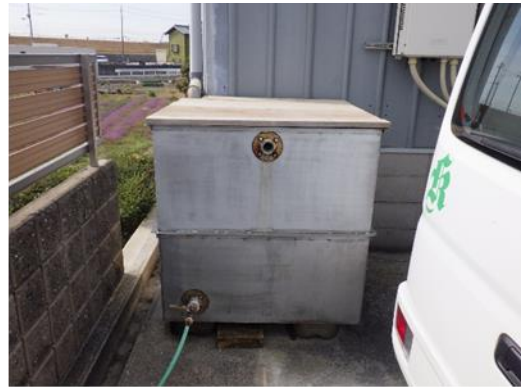
貯留タンクの設置
