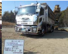
積み込み完了
