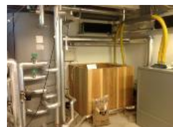
↑オーストリア製のペレットボイラー (右) と、ペレット燃料を入れるサイロ (真ん中) と蓄熱槽 (左)。家庭用ペレットボイラーとしては全
