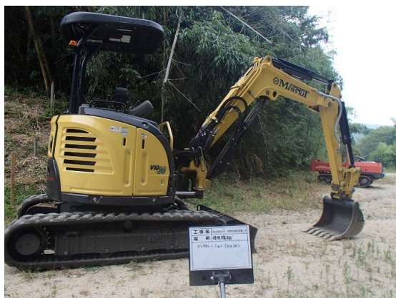
環境に考慮した工法を採用している
