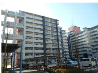
本山第一住宅8号棟新築
