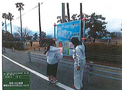
建設現場での防災広報
