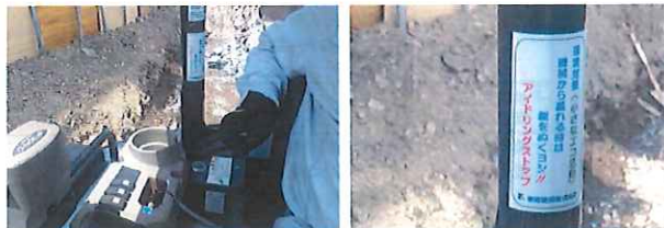
建設現場でのアイドリングストップ(重機)
