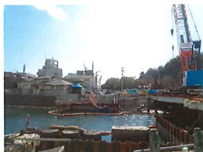
建設現場の汚濁防止膜設置
