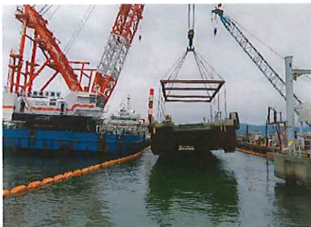
R7徳土 徳島小松島港(沖洲外地区)徳・東沖洲浮 棧橋撤去工事
