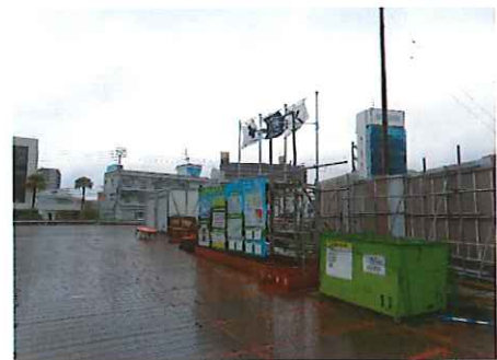
助任橋橋梁下部工事 (斎藤・兼徳・バンドウリメイクJV)
