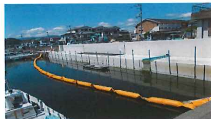
汚濁防止膜設置工事
