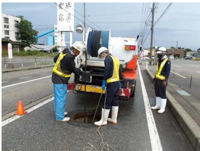
【排水管洗浄作業】
