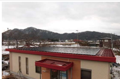
太陽光パネル設置①
