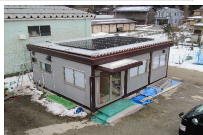
太陽光パネル設置②
