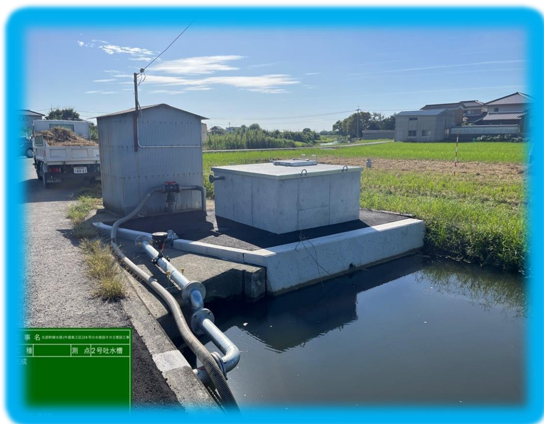
北部幹線水路（牛屋島工区）24号分水施設その2 建設工事
