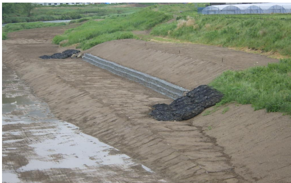
(一) 加古川水系 加古川護岸修繕工事
