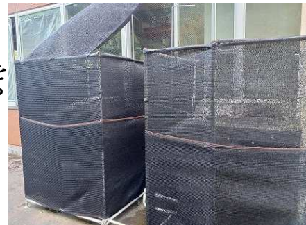
（写真1）室外機に日陰カバー設置
