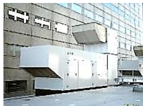
ガスタービン発電装置 2500kVA
