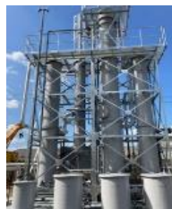
液体式アセチレンガス清浄装置
