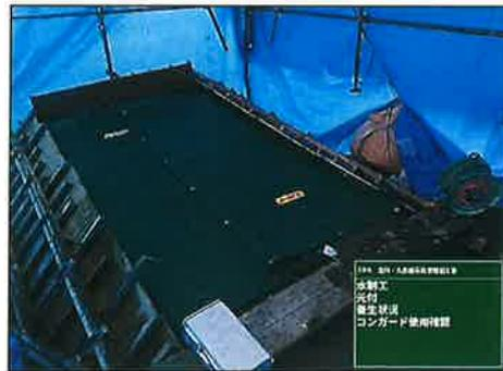
コンクリート養生に従来ジェットヒーターを使用していたが、電熱
