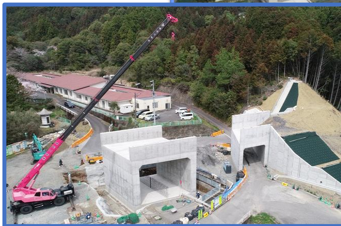
ICT活用工事現場
