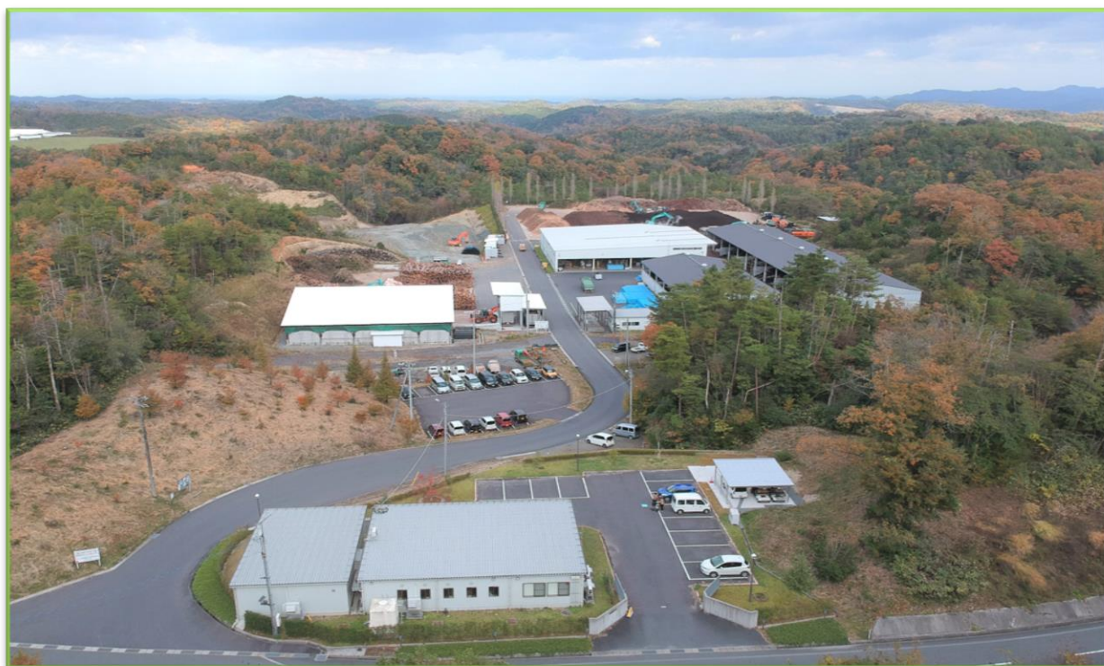
本社社屋及び小松地工場を望む
