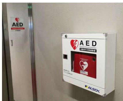
[ 本社ビル 1 階 AED 設置 ]
