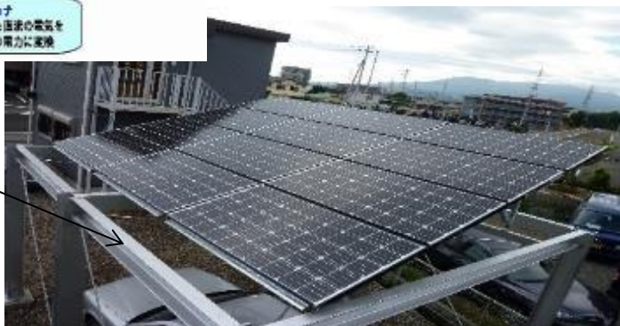
太陽電池モジュールの設置
