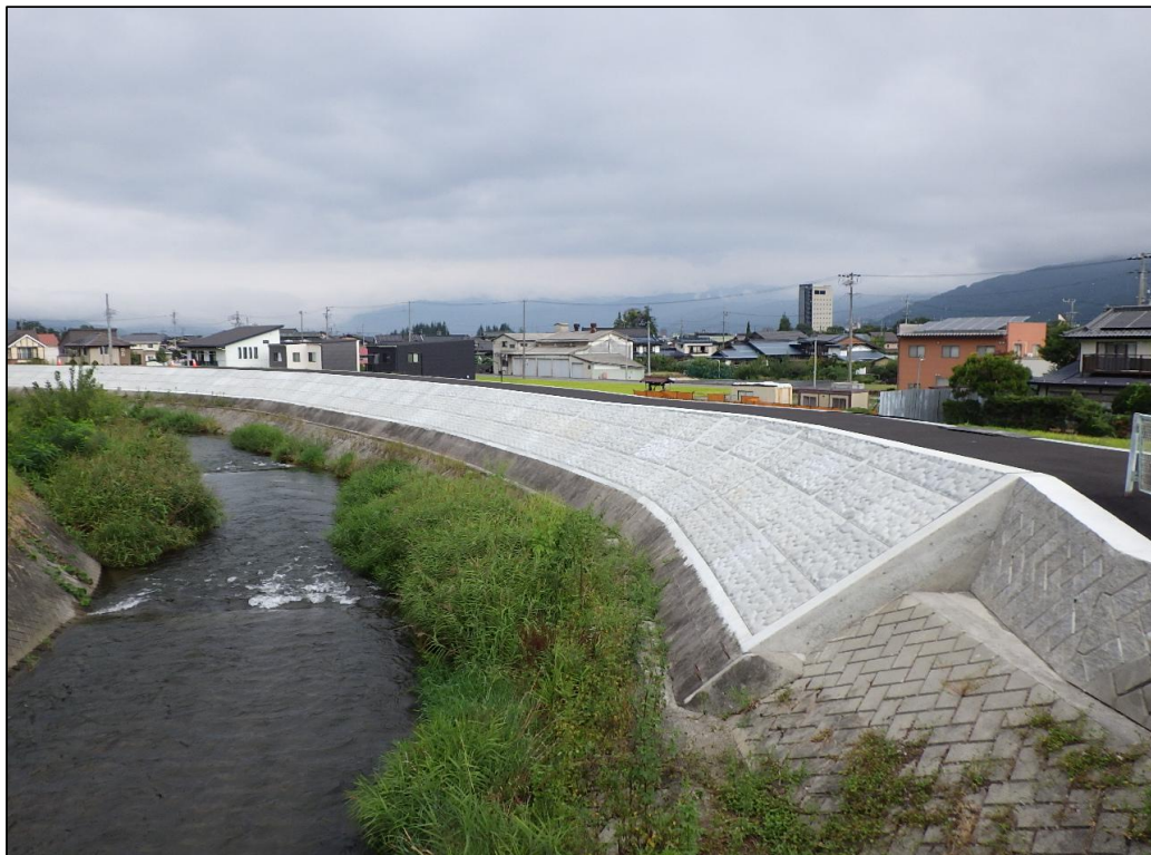
令和5年度県単河川改修(補正)工事姫宮橋下
