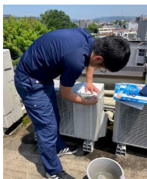
6.17 屋上のエアコン 室外機遮熱シール張替え。
