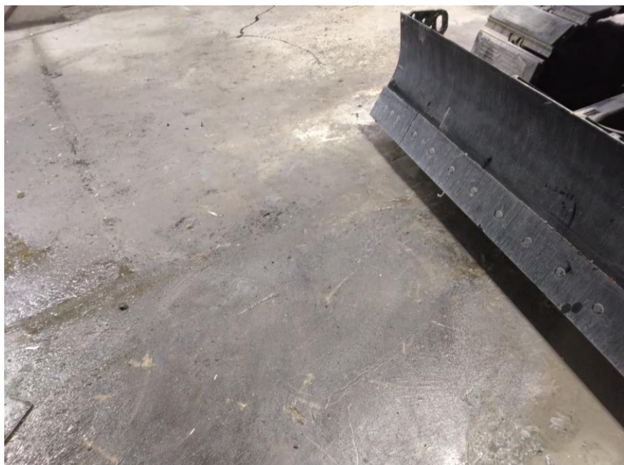
油処理、洗浄完了
