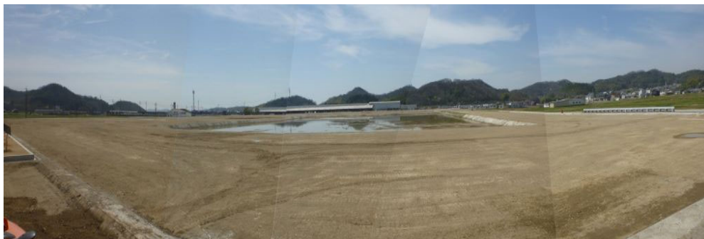
施工例:加西インター産業団地整備工事
