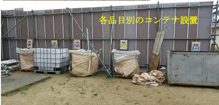
マニフェストの配布及び管理の徹底と現場の分別用コンテナの設置による取組状況
