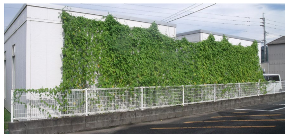
テナント棟壁面緑化(平成26年度)
