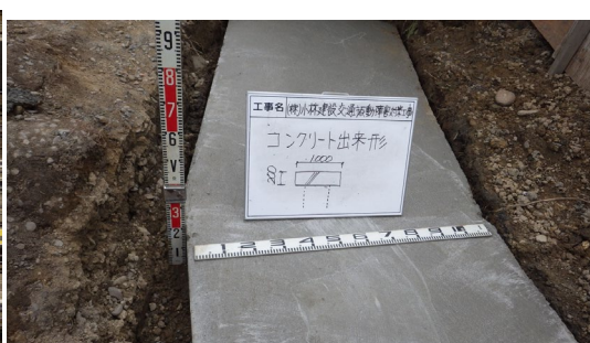
押さえコンクリート
