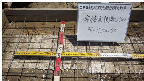
押さえコンクリート配筋
