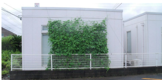
テナント棟壁面緑化(平成25年度)
