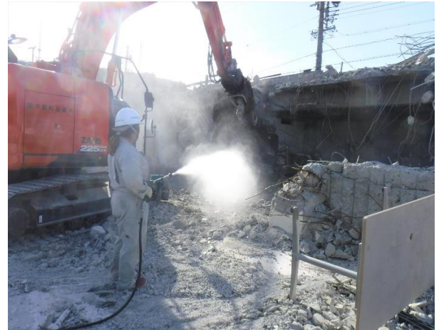
<散水による粉塵対策>
