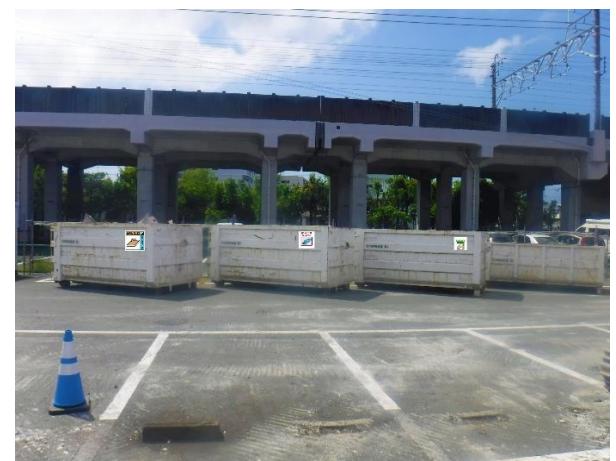
<廃棄物の分別解体②>
