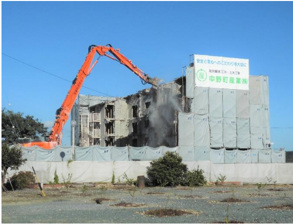
<工事中のシート養生>
