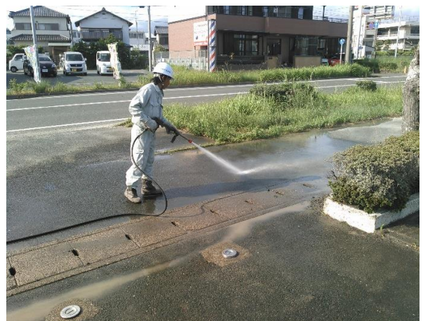
<工事完了後の道路清掃>
