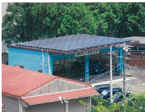
車庫設置 太陽光発電システム(売電)
