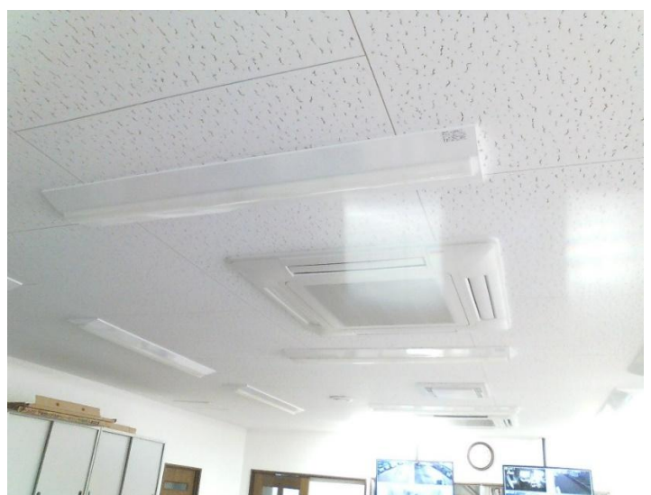
省エネエアコン及び照明LED化
