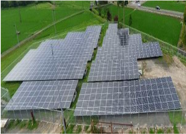
太陽光発電設備 24.08kw
