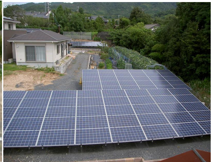
太陽光発電設備 24.08kw
