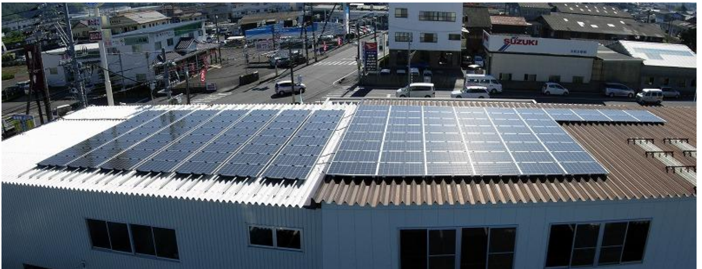
太陽光発電設備 24.08kw
