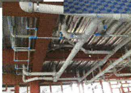
公共施設の設備工事
