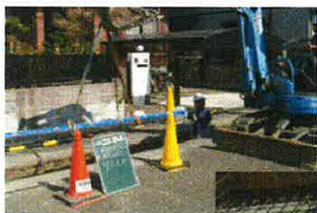
道路の水道本管工事
