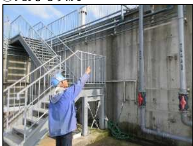
②漏洩箇所水洗
