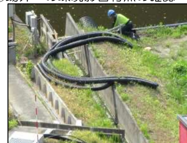
⑥補修配管の漏洩有無確認
