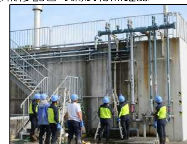
⑥補修配管の漏洩有無確認
